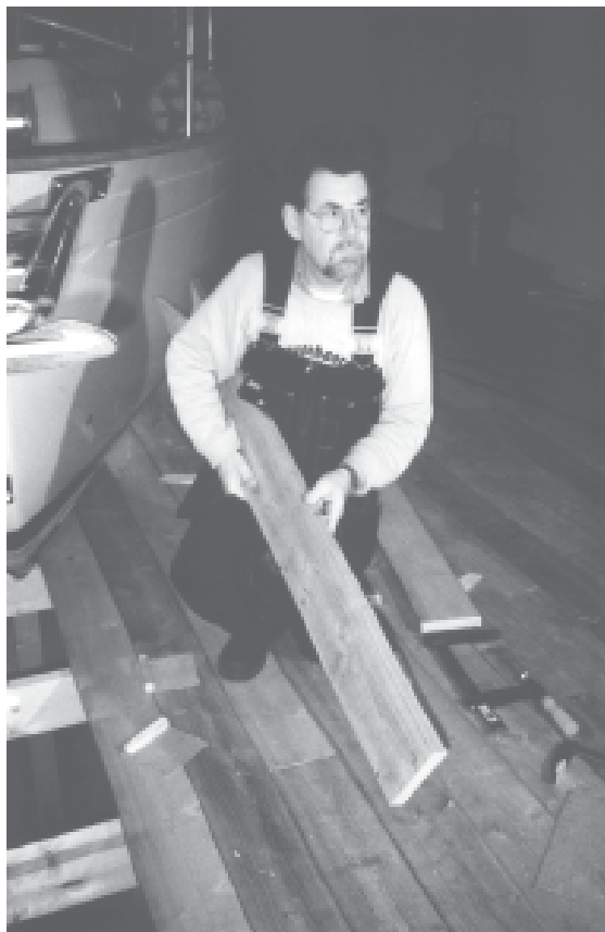
Kjell-Åke Gustavsson lägger golv i båthallen.
